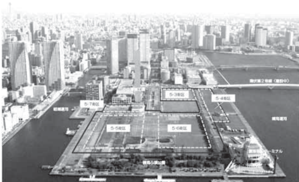
【市街地再開発事業の着手前の状況（航空写真）】
